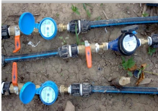
شکل ۲- کنتورهای اندازه‌گیری آب مصرفی در آبیاری قطره‌ای
