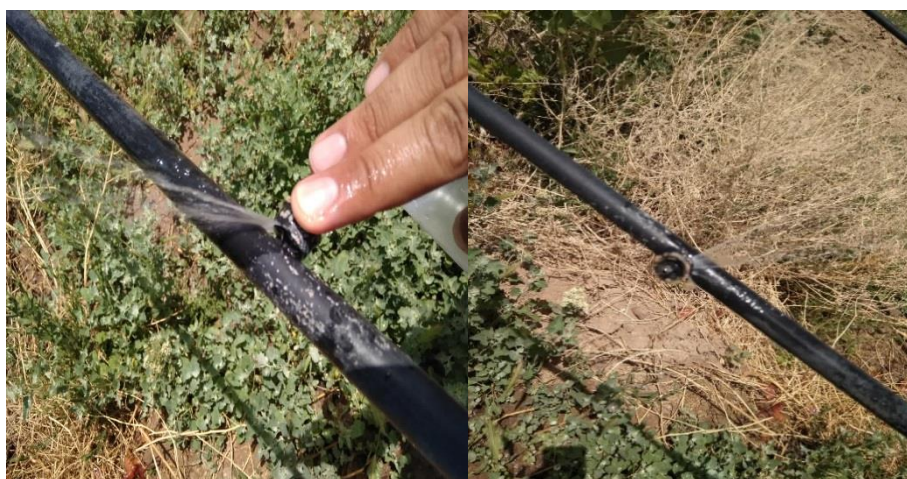
شکل ۹- نشت لوله‌های لترال در اثر افزایش فشار پشت قطره چکان‌ها
