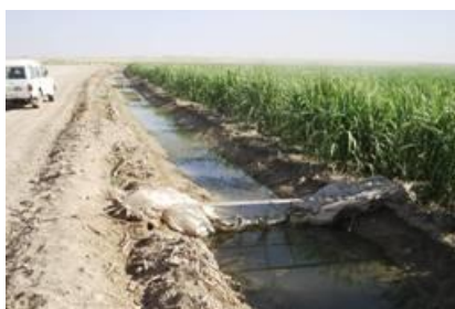
شکل ۲: مقایسه هدر رفتن آب در دو روش آبیاری هیدروفلوم (سمت راست) با روش سنتی (سمت چپ)
