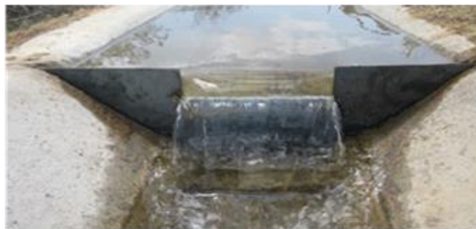
شکل ۳- نمایی از نصب سرریز مستطیلی بر روی کانال انتقال آب
