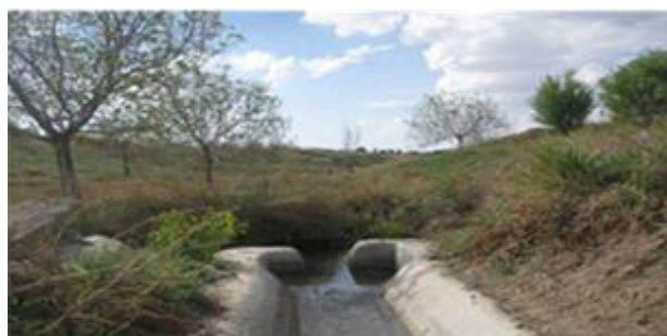
شکل ۴- نمایی از ورودی کانال انتقال آب
