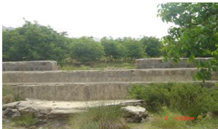
شکل ۳- نمایی از بند سیمانی اجرا شده در حوضه
