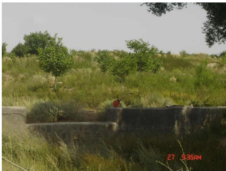
شکل ۲- نمایی از عملیات بیومکانیکی اجرا شده در حوضه دره مرید
